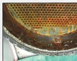
被水垢腐蚀的冷凝器
